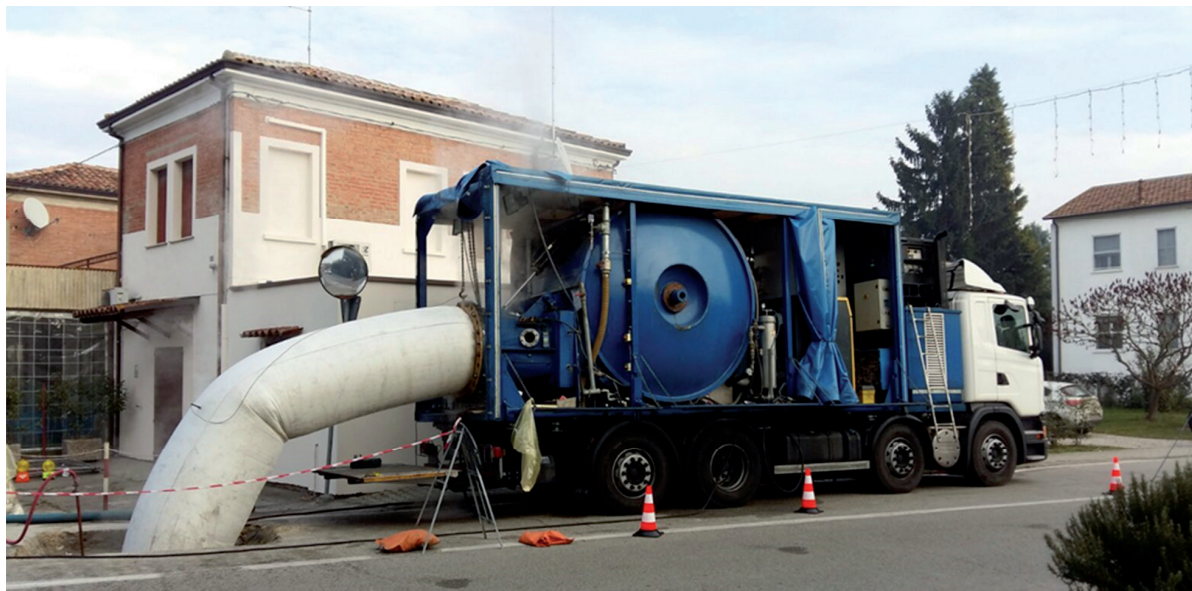
Fig. 5: CIPP inversione di un liner strutturale mediante pressione d'aria e termopolimerizzazione con flussaggio di aria-vapore.
