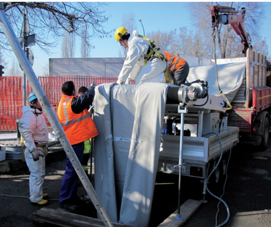
Fig. 6 – 7: CIPP inserimento a traino e termopolimerizzazione mediante pressione ad aria e innesco ad irraggiamento UV.
