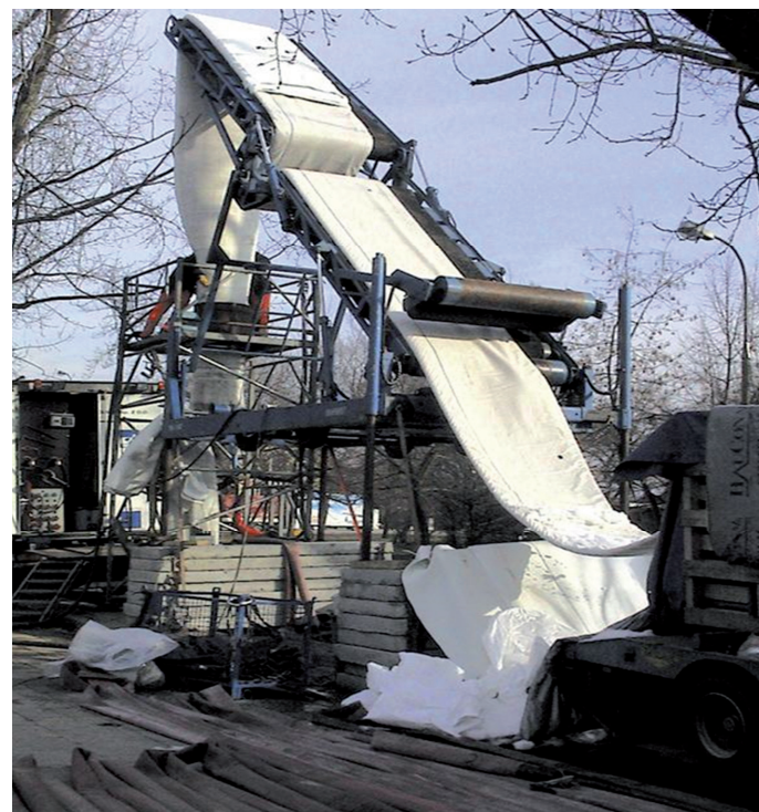
Fig. 4: CIPP Inversione di un liner strutturale mediante battente d'acqua e termopolimerizzazione con circolazione d'acqua calda.
